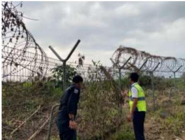
**Gambar 4 Personel *Aviation Security* melakukan pengecekan pada kawat duri yang terlepas dari pagar perimeter**
