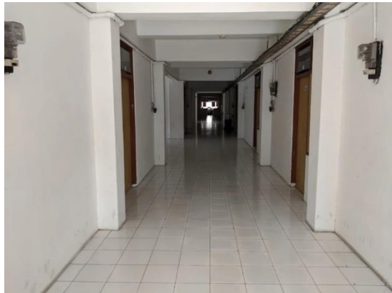
Gambar 1.2 Keadaan Fasilitas Serta Kualitas Dari Apartemen Grha Aparna.
