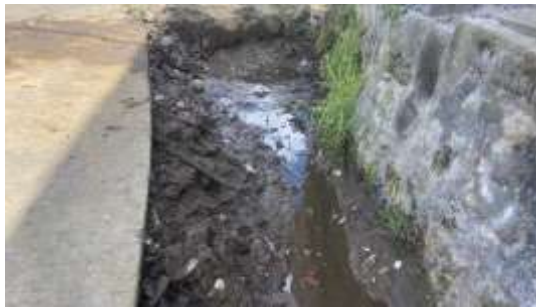
Gambar 6. Selokan yang telah dibersihkan
